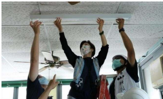
愛築積-能源公益計畫- LED 節能燈具 安裝專案
