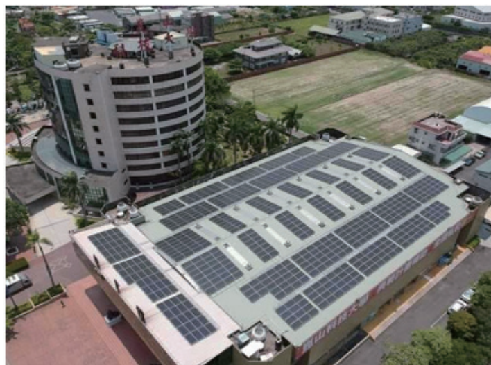
本校建築物屋頂建置太陽能發電系統
